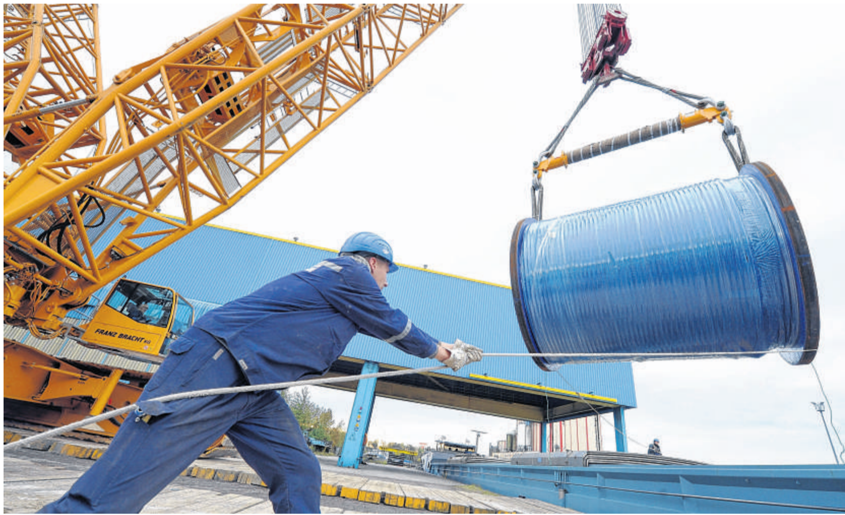
Haspel am Haken: 287 Tonnen wiegt jede der vier Riesen-Rollen, die der Raupenkran lifet. Menschenkraft ist dennoch gefordert – bei der Feinausrichtung. Fotos: Martin Möller
