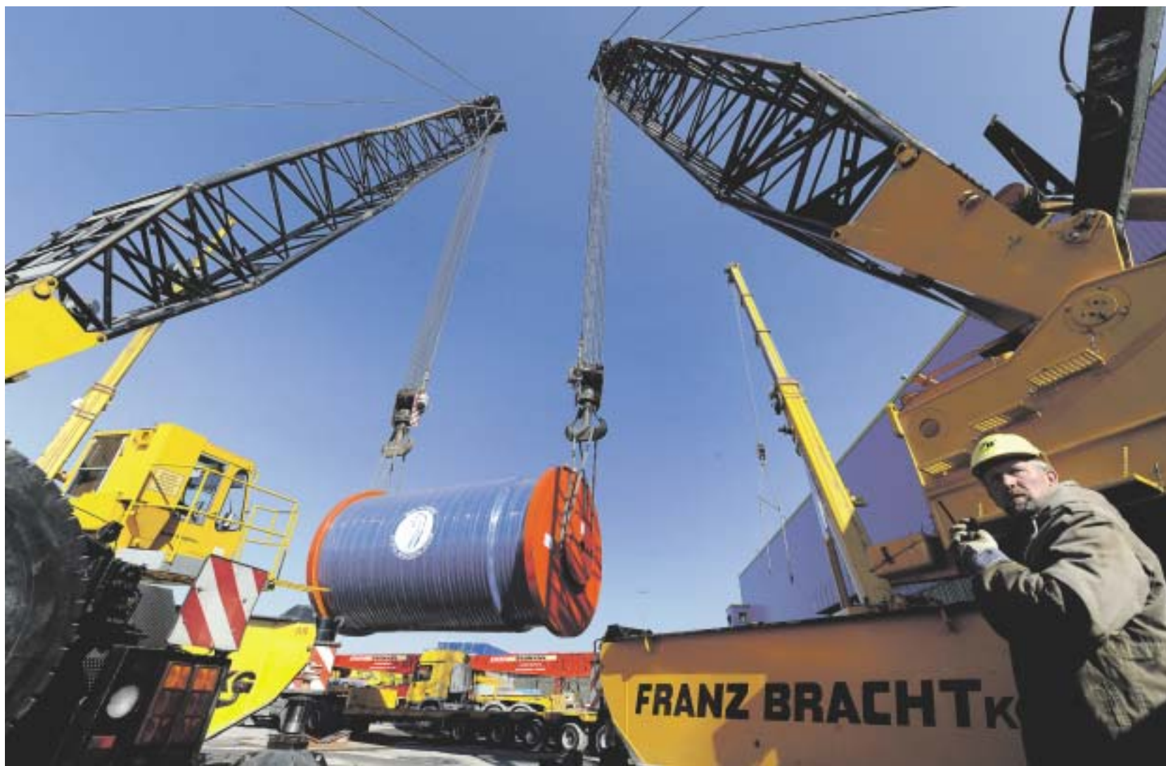
Zusammenspiel der Kräfte. An zwei Kranrossen wurde die 360 Tonnen schwere Haspel vom Tieflader gehoben. Der Schwertransport war 76 Meter lang. Foto: Thomas Schmidtko
