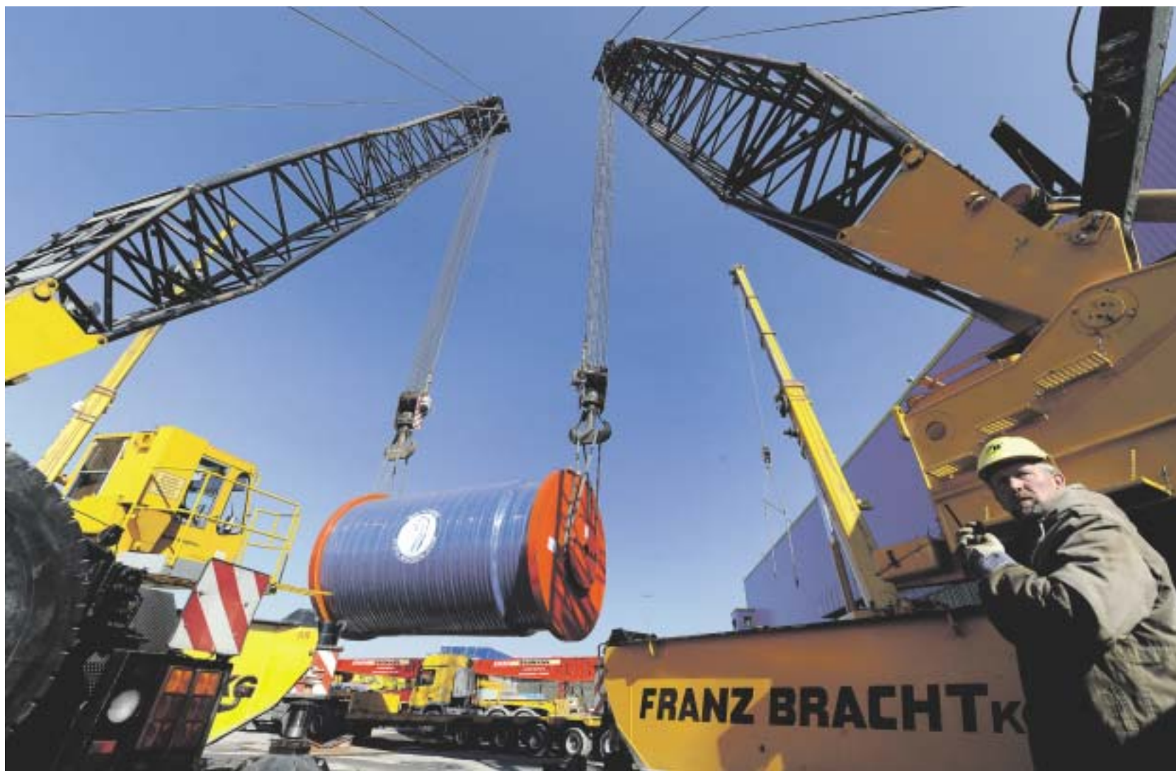
Zusammenspiel der Kräfte. An zwei Kranrossen wurde die 360 Tonnen schwere Haspel vom Tieflader gehoben. Der Schwertransport war 76 Meter lang. Foto: Thomas Schmidtko
