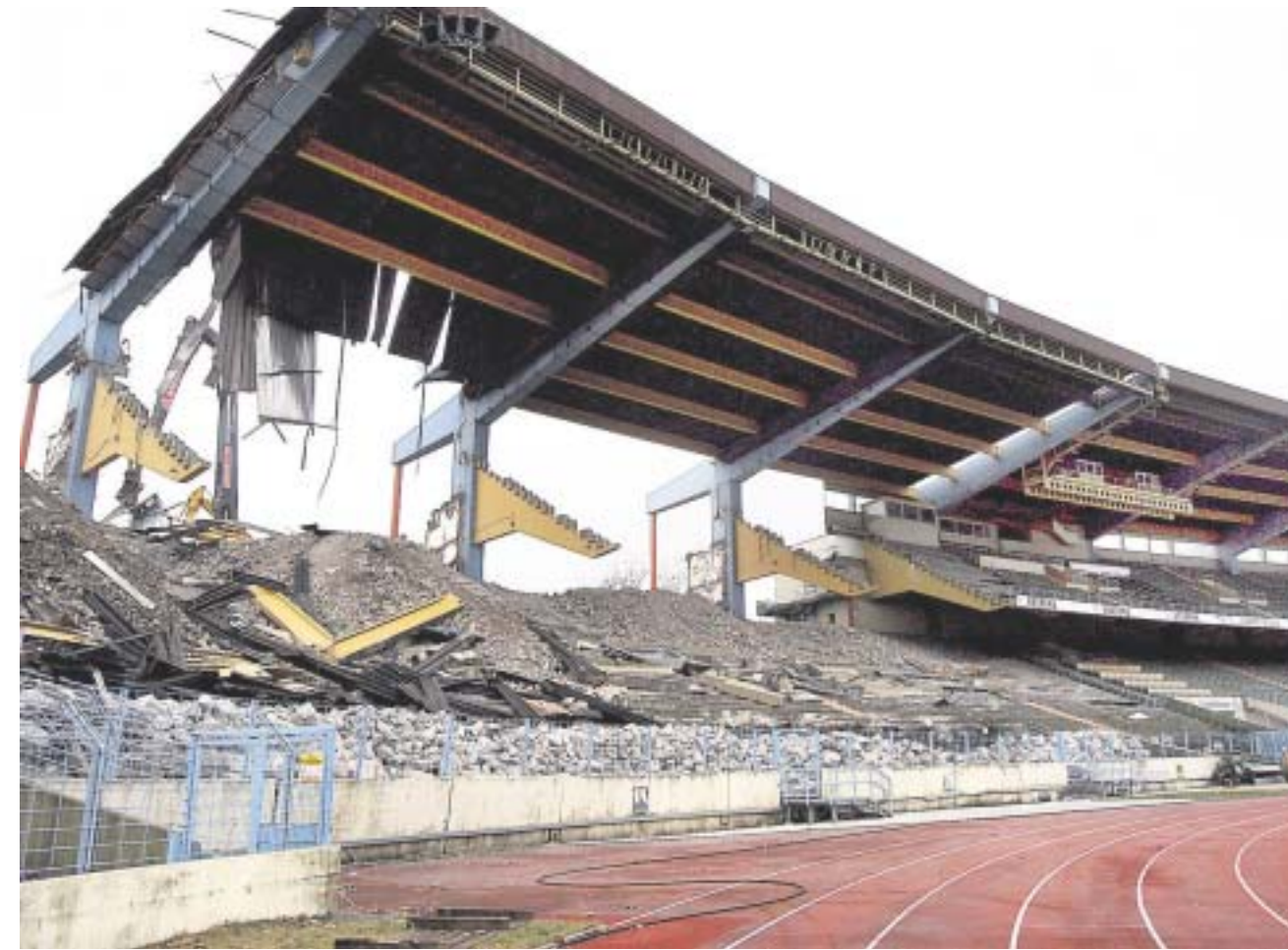
Einen Teilabriss des Parkstadions gab es bereits 2004. Nun soll der Rest weichen - u.a. für ein Regionalligastadion. Foto: WAZ, Archiv
