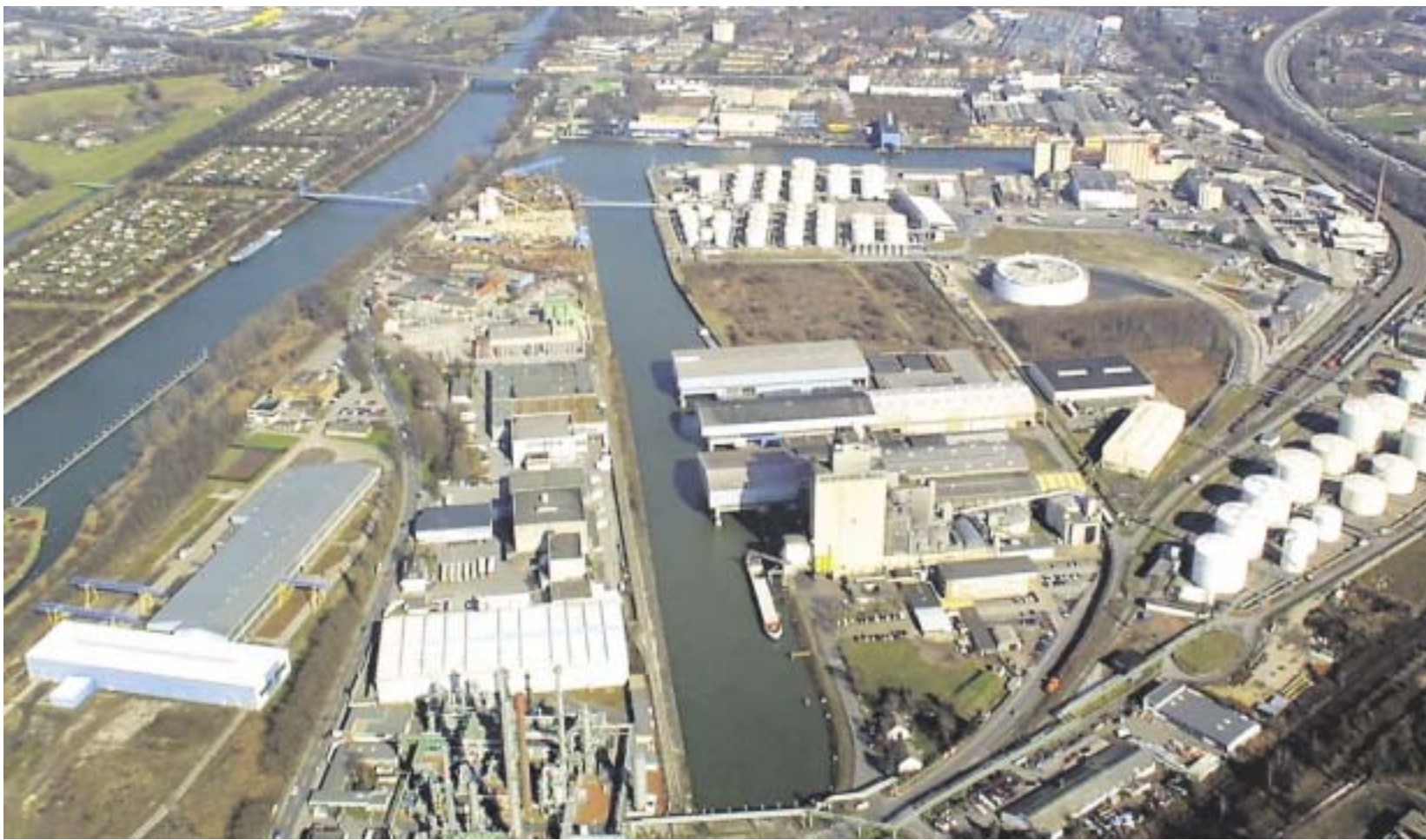
Der Stadthafen, ein eingezäuntes Areal? Das befürchtet der Betreiber Gelsen-Log, wenn das Land seine Pläne durchsetzt.
