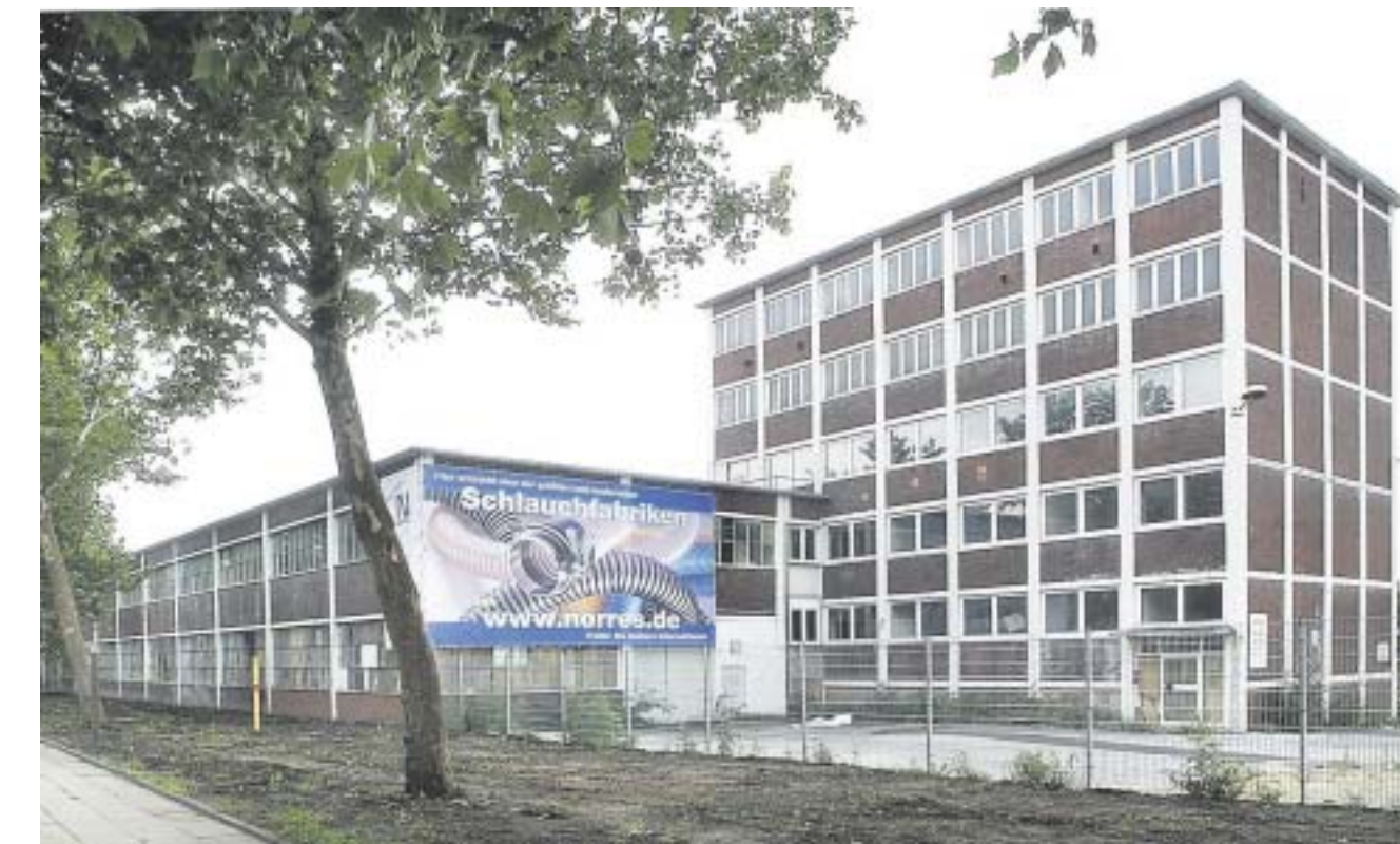
Das neue Werk II von Norres: die ehemaligen Seppelfricke-Hallen an der Kurt-Schumacher-Straße.
